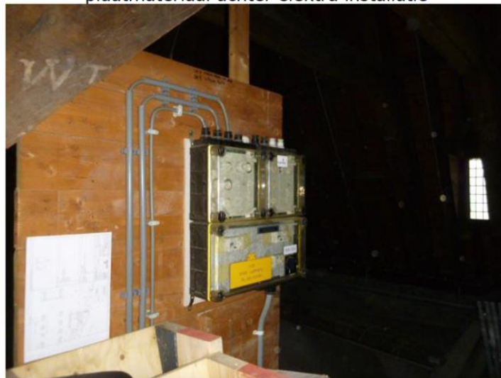
Zolder boven winkel, plaatmateriaal achter elektra
