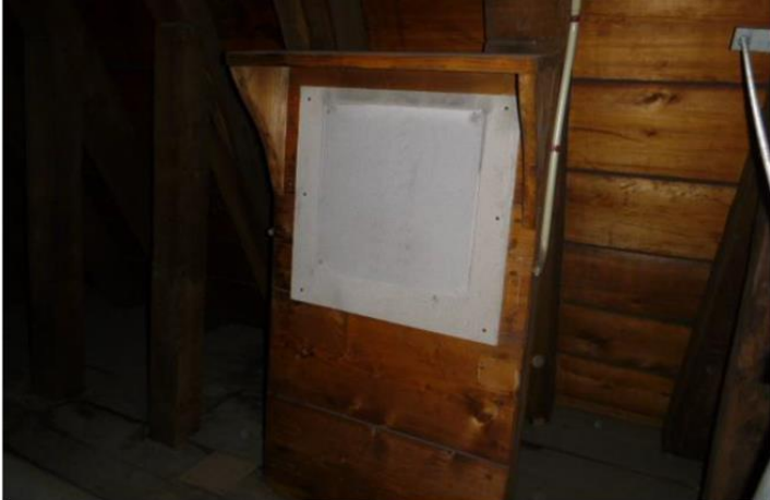
Plaatmateriaal zolder boven gewelven: Damzijde plaatmateriaal
