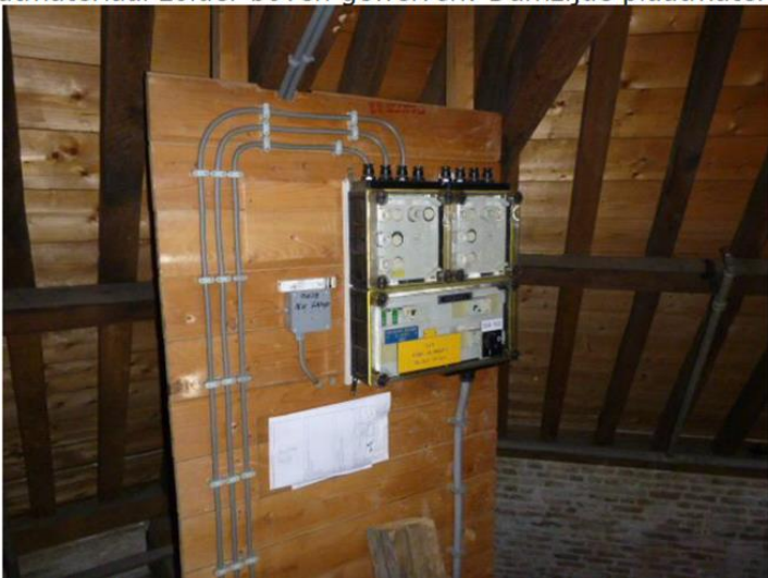
Zolder boven Boeiekapel, plaatmateriaal achter elektra
