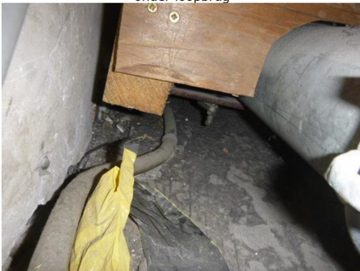
Kerk boven hoofdingang: plaatmateriaal onder sprinklerleiding onder loopbrug
