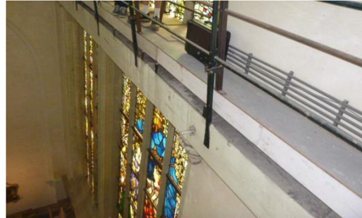
Kerk boven hoofdingang: plaatmateriaal onder sprinklerleiding onder loopbrug
