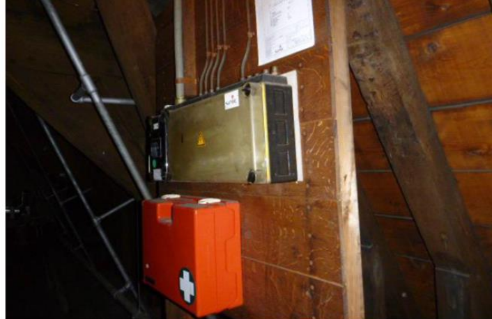
Plaatmateriaal zolder boven gewelven: achterzijde, plaatmateriaal achter elektra installatie
