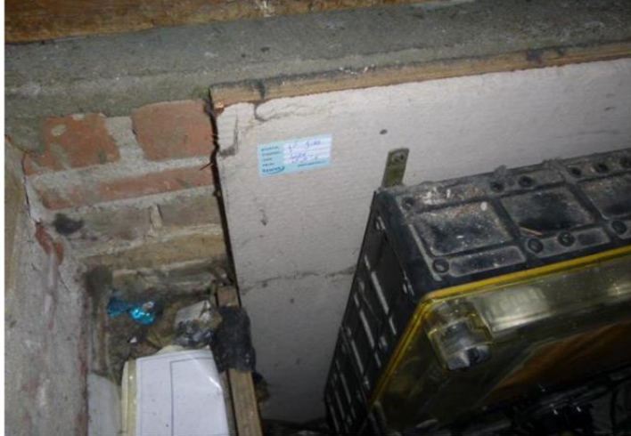
Plaatmateriaal elektraput 4
